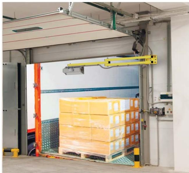
Кронштейн с прожектором устанавливается внутри помещения в непосредственной близости от края проема. Кронштейн с двумя поворотными осями и подвижное крепление светильника позволяют точно позиционировать положение прожектора и добиться максимальной освещенности пространства внутри кузова автомобиля.
